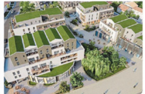
Voilà à quoi doit ressembler le programme immobilier « Le forum », dans le centre. Le chantier doit être terminé en 2026.
