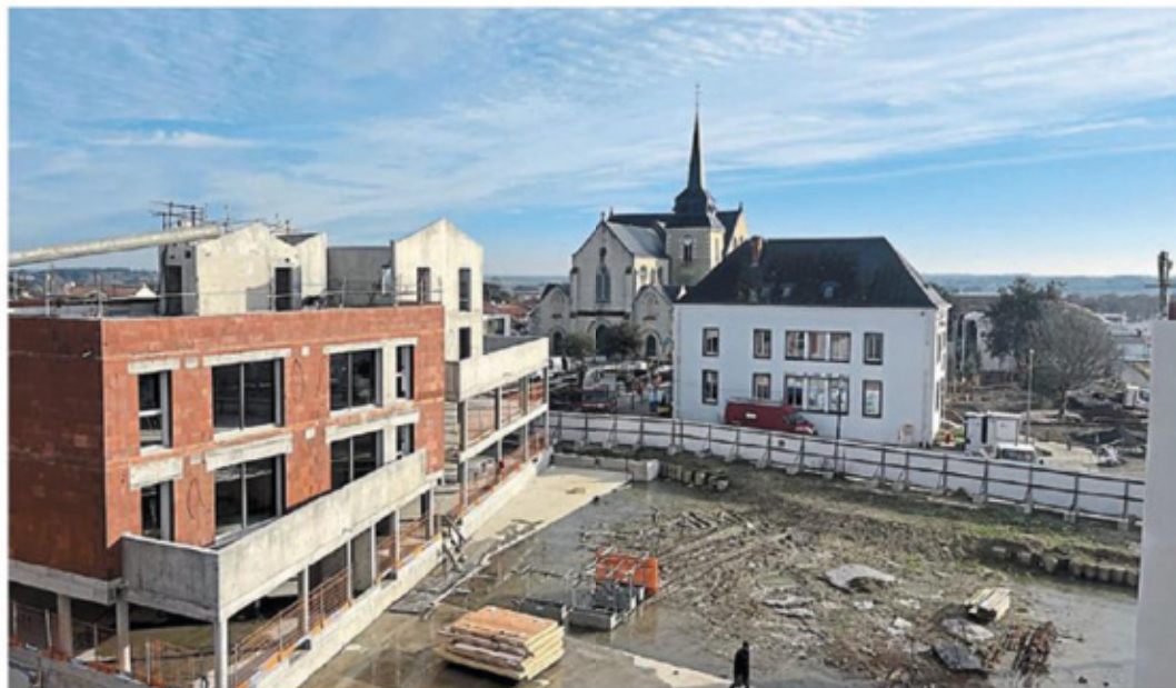
Les travaux de maçonnerie des immeubles de la ZAC du centre-ville à Saint-Hilaire-de-Riez s'achèvent en ce mois de janvier.
