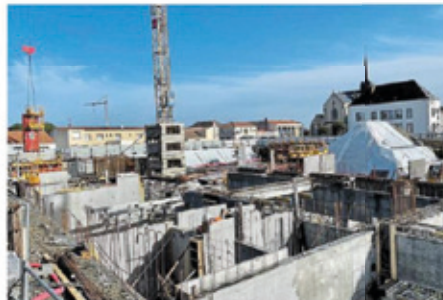
« Le chantier avance plutôt bien et nous sommes dans les temps », se félicite Jocelyn Merceron, PDG du groupe Satov.
