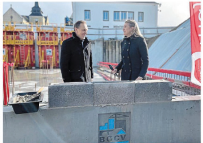
Ce vendredi 9 février, la première pierre du programme immobilier « Le forum » a été posée en la présence de Jocelyn Merceron, PDG du groupe Satov et de la maire de Saint-Hilaire-de-Riez, Kathia Viel.
