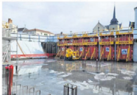
30 000 m 2 de terre pour créer le sous-sol
