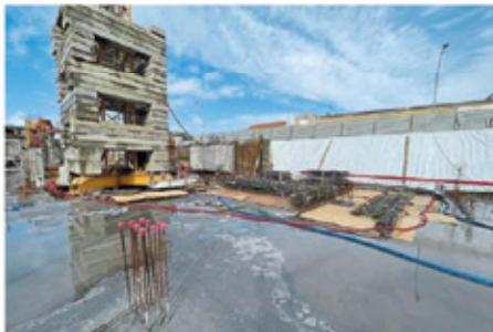
Dans le sous-sol, la dalle en béton mesure 4 000 m 2 , avec 45 cm d'épaisseur.
